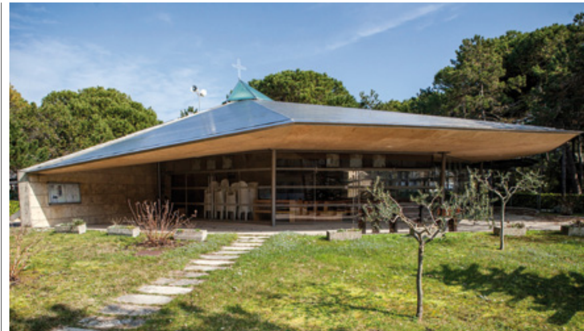
Chiesa dei Santi Ermacora e Fortunato. Vista dell'ingresso
